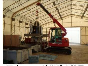
写真3-3 洗浄槽内設置
