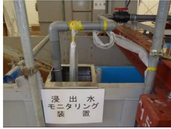
写真3-5 浸出水モニタリング装置
