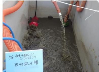
写真-9 泥水として回収した細粒分
