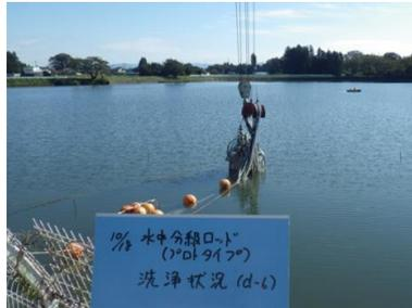
写真-8 底質分級洗浄状況
