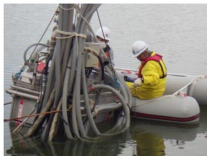
写真-13 施工中濁度測定状況
