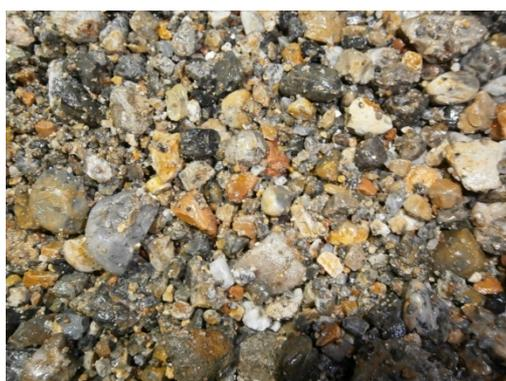
写真 2.16 富岡町役場バス車庫屋上の洗浄後の状態（ポットミキサー＋高圧水洗浄機）
